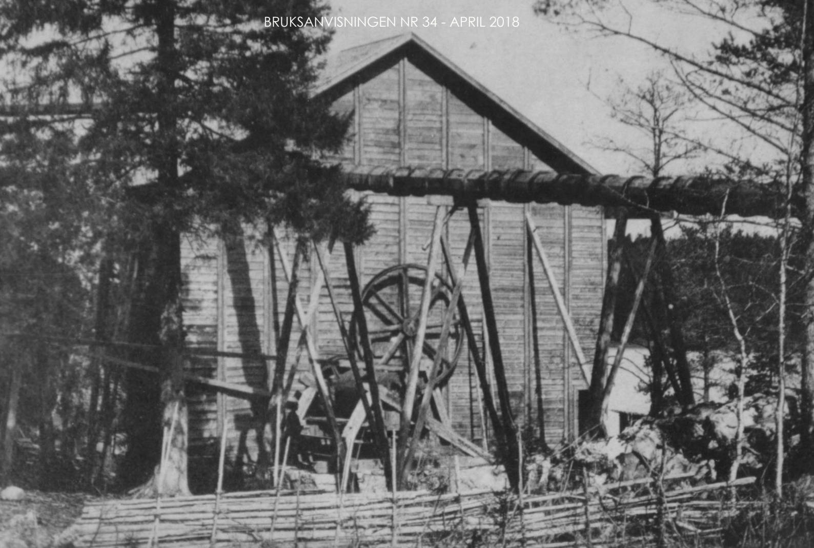
Hjulhuset året 1910. Konstruktionen var 40 år gammal och man kan tydligt se vattenledningen som leder in till överfallet som fick hjulet att snurra. FOTO: REPRODUKTION AV HARRY LINDBLAD
